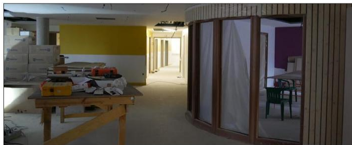
■ Le hall central du rez-de-chaussée prend des couleurs. Photo Didier DAVID
