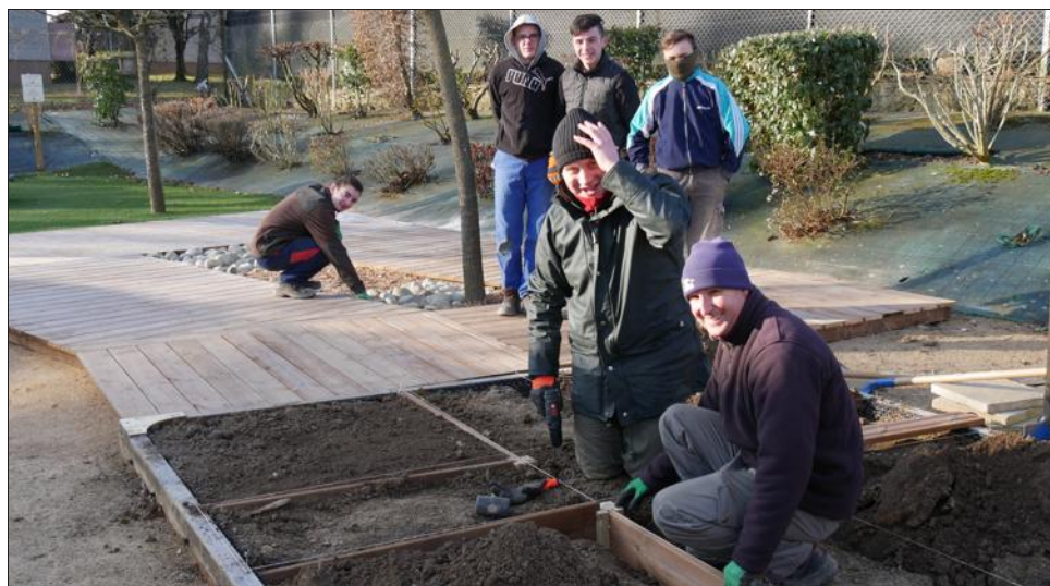
■ Emmanuel Devaux, professeur, supervise le chantier. Photo Didier DAVID
